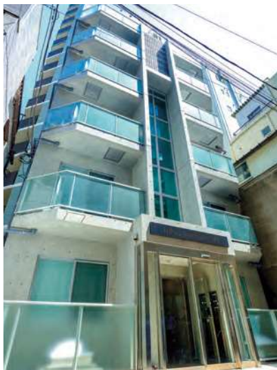
「Tokyo Shimbashi 579」外観
